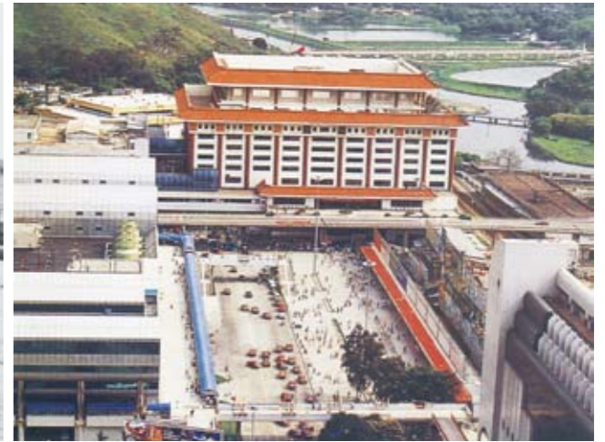
集团与外商合作营建的罗湖联检大楼
